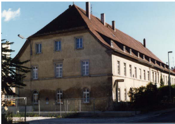
Israelitische Elementarschule (rechter Teil des Gebäudes), Landwehrstraße 23. Sie enthielt nach der Zerstörung der Synagoge in der Reichspogromnacht ab März 1939 auch den Gebetsraum. Das ganze Gebäude (Landwehrstraße 21 – 23) diente zuletzt als „Judenhaus“.
